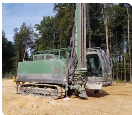
Erkundungsbohrungen Exploration drillings
