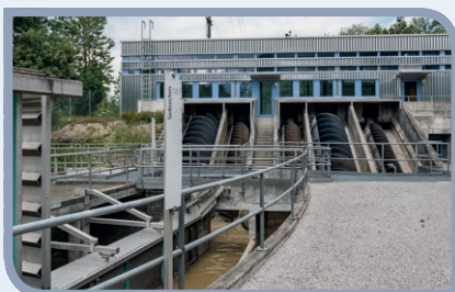
Hebewerk mit Schneckenpumpe Lift Station with Worm Pump
