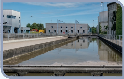
Vorklärung Primary Clarifier
