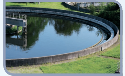
Nachklärbecken Secondary Clarifier
