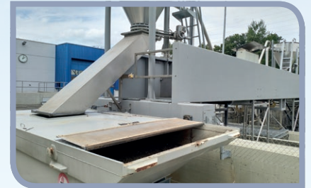
Rechengut und Sand Screenings and Sand
